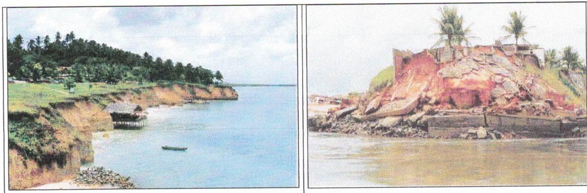
**Fig. 10 e 11.** Detalhe de área de erosão de falésias com construção de restaurantes e escadas. Detalhe da destruição de muro de arrimo por ação das correntes marinhas, vendo-se a esquerda as barracas da Praia do Cachorro.
