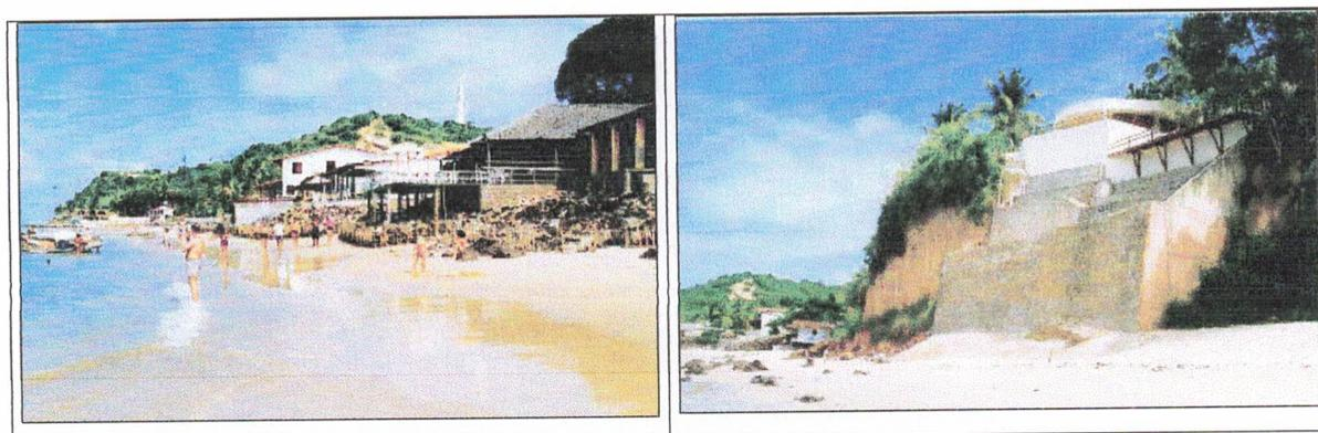
**Fig. 24 e 25.** Praia de Pipa. A foto 24 apresenta o esforço dos proprietários das construções para conter a ação das ondas. Na maré alta, as edificações são banhadas pelo mar como mostra a Fig. 23. A foto 25 é um exemplo de construção que tenta reduzir a erosão das falésias, acentuando o desmoronamento pela ação das ondas em áreas adjacentes. As fotos foram tiradas em período de baixa mar.
